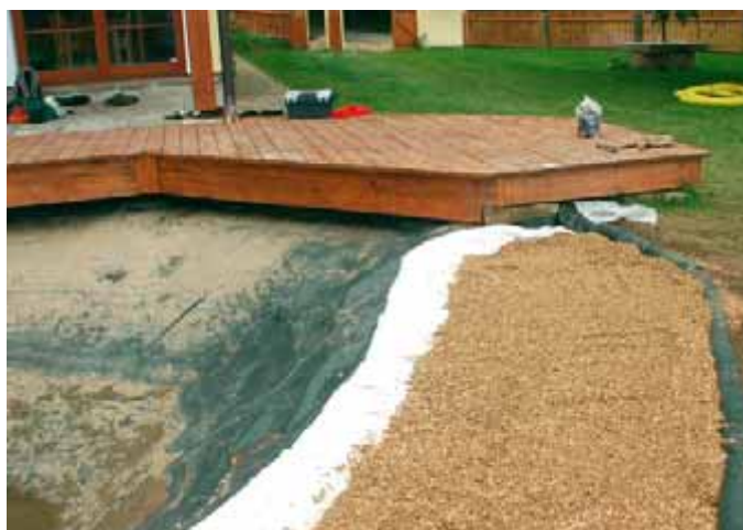
Hydroizolační fólii je nutné chránit geotextilií
